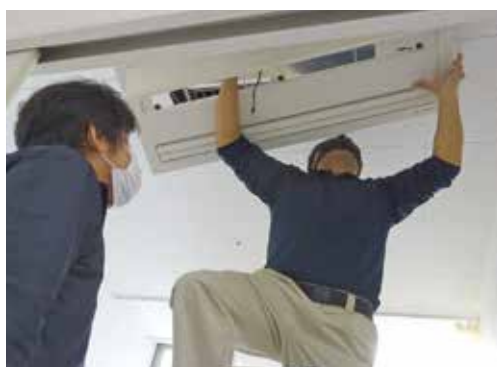
「臨時清掃」でエアコン内部の清掃
