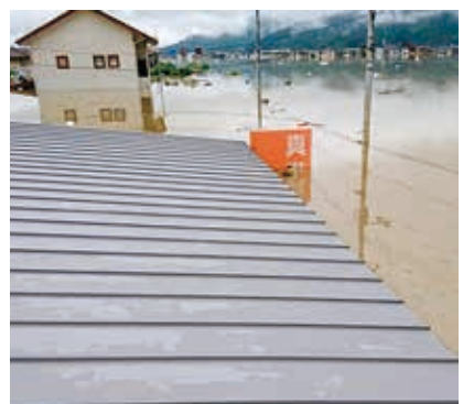
看板上部まで浸水
