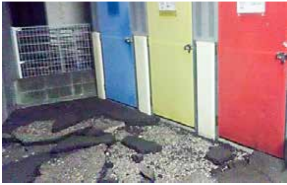
アスファルトがめくれたゴミ捨て場
